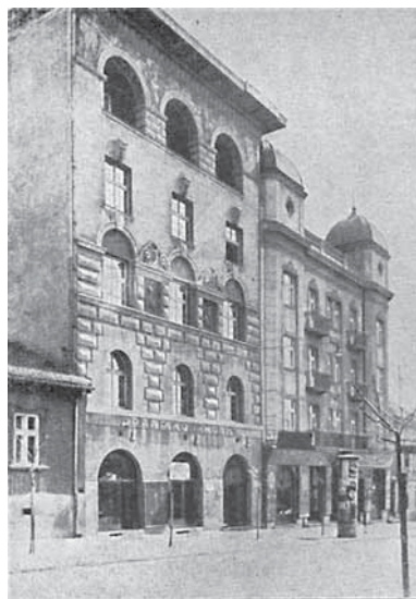
Milan Zloković, Šojatova kuća , 1926.
