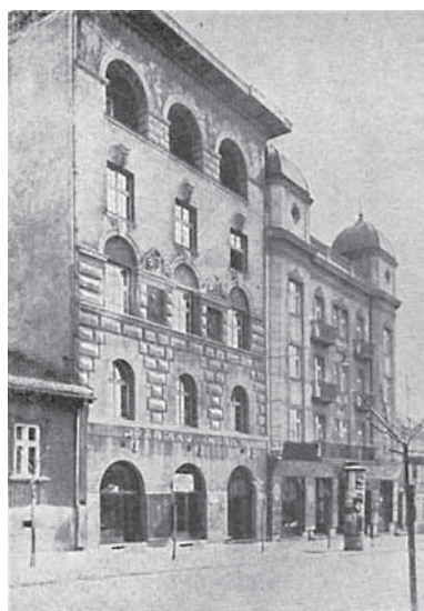
Milan Zloković, Šojatova kuća , 1926.
